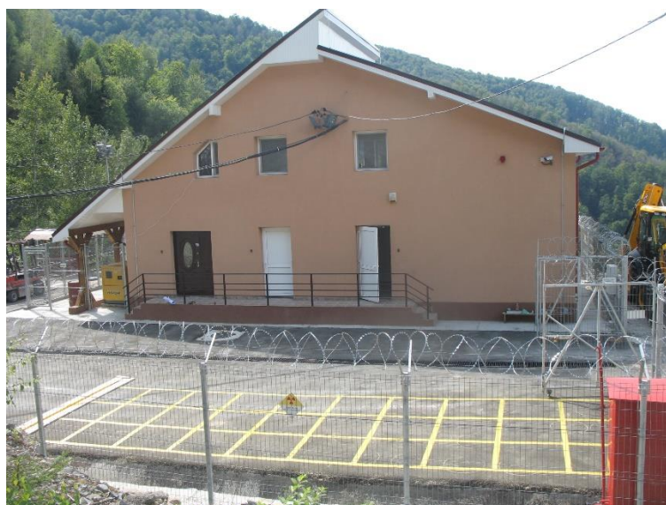
Sistemul de recepție al coletelor cu deșeuri radioactive condiționate
